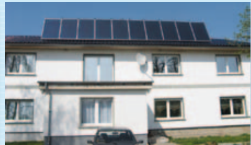
Hybridanlage zur Trinkwassererwärmung und Heizungsunterstützung wasser-/luftseitig, mit Anbindung an kontrollierte Wohnraumlüftung: 200 % Leistung im Vergleich zu herkömmlichen Flachkollektoranlagen
